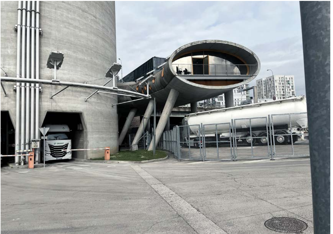
[photographies] La matière arrive en train et est conduite dans les silos par le système pneumatique
