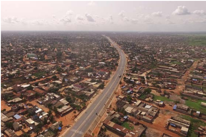
LE CORRIDOR AU NIVEAU DE COTONOU, 2018 (© ACML).
